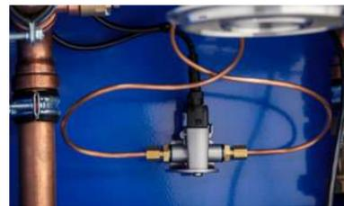
Capteur de pression différentielle Grundfos
